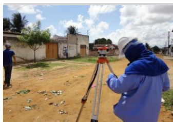
REDE COLETORA Foto 1 - Locação de rede bacia AN e BN
