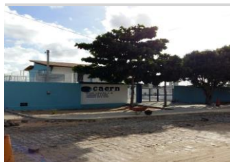
ELEVATÓRIA Foto 10 - Vista externa EEE 01AN
