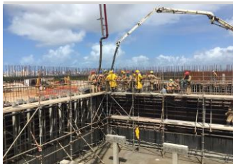
ESTRUTURA Foto 5 - Concretagem UASB
