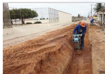
REDE COLETORA Foto 4 - Reaterro com compactação mecânica
