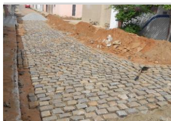
REDE COLETORA Foto 5 - Recomposição pavimentação em paralelo
