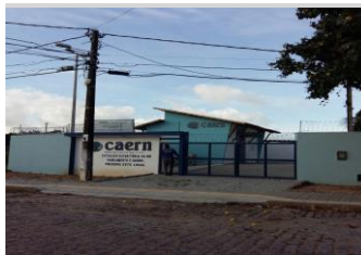
ESTAÇÃO ELEVATÓRIA Foto 7 - EEE 04BN
