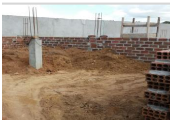
ELEVATÓRIA Foto 9 - Aterro do caixão do abrigo do gerador da EEE 01AN
