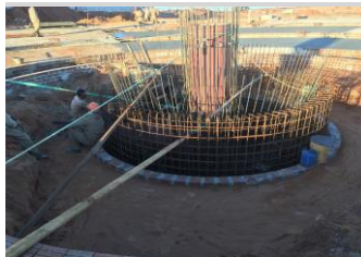
ESTRUTURA Foto 3 - montagem ferragem Decantador secundário
