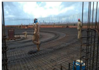
ESTRUTURA Foto 2 - montagem ferragem Decantador secundário
