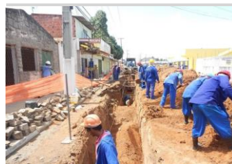
REDE COLETORA Foto 6 - Reaterro com compactação manual de vala
