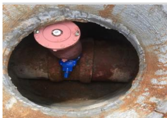
EMISSIONÁRIO Foto 11 - Tê em fôlo 700x100mm, registro 100mm, e ventosa na linha de Recalque de 700mm
