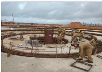
ESTRUTURA Foto 1 - montagem ferragem Decantador secundário
