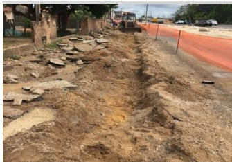
REDE COLETORA Foto 1 - Sinalização, demolição de pavimentação asfáltica
