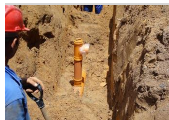
LIGAÇÕES Foto 8 - Reaterro manual com vista para plug, selim e tê de ligação
