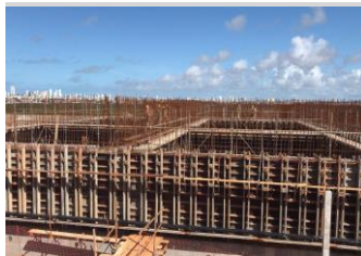
ESTRUTURA Foto 7 - Montagem de formas UASB 04
