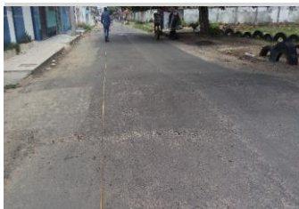
REDE COLETORA Foto 5 - recomposição asfáltica
