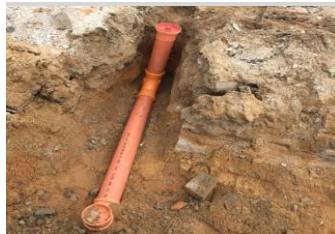
LIGAÇÃO Foto 2 - Ligação de esgoto (ramal) com instalação de TII
