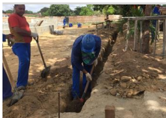
ELEVATÓRIA Foto 11 - Execução escavações muro de contrbno EEE 01 AN
