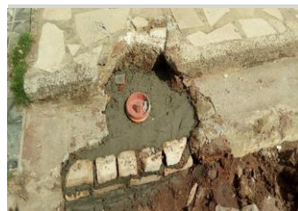
LIGAÇÕES Foto 10 - Execução de tl
