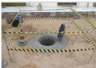
REDE COLETORA Foto 7 - Instalação de tampão de ferro em poço de visita
