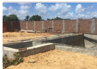
ELEVATÓRIA Foto 12 - Execução alvenaria muro de contrbno EEE 01 AN
