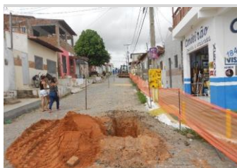
REDE COLETORA Foto 3 - Execução de sondagens
