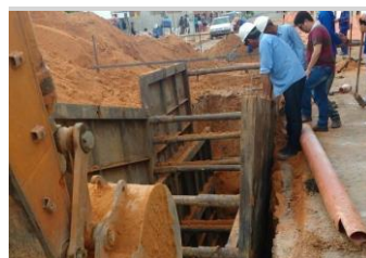
REDE COLETORA Foto 2 - Escavação mecânica e uso de escoramento tipo blindado
