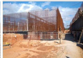
ESTRUTURA Foto 8 - Montagem ferragem tanques de aeração
