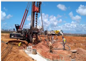
ESTRUTURA Foto 9 - Execução de estacas no decantador secundário
