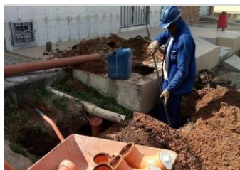
LIGAÇÕES Foto 9 - Execução de tl
